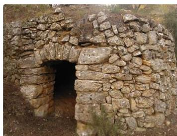
Les bories sont donc des cabanes en pierre sèche dans des régions qui possèdent les tonnes de matériaux nécessaires : la pierre débitable en lauzes, en pierres plates ou en moellons.
