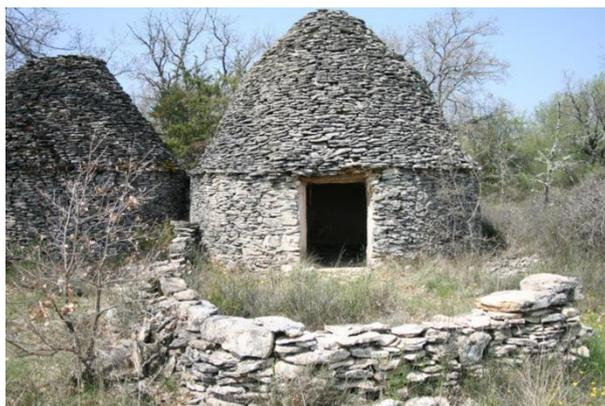
Sur le faitage, pour achever l'ensemble, on pose de grosses pierres plates qui assurent la stabilité de la voûte. Il faut prévoir une entrée qui, le plus souvent, est basse. Il faut se préserver, autant que possible du froid. Dans la plupart des cas, une grande dalle est posée en guise de linteau. Plus rarement, on peut rencontrer un arc clavé en moellons.
