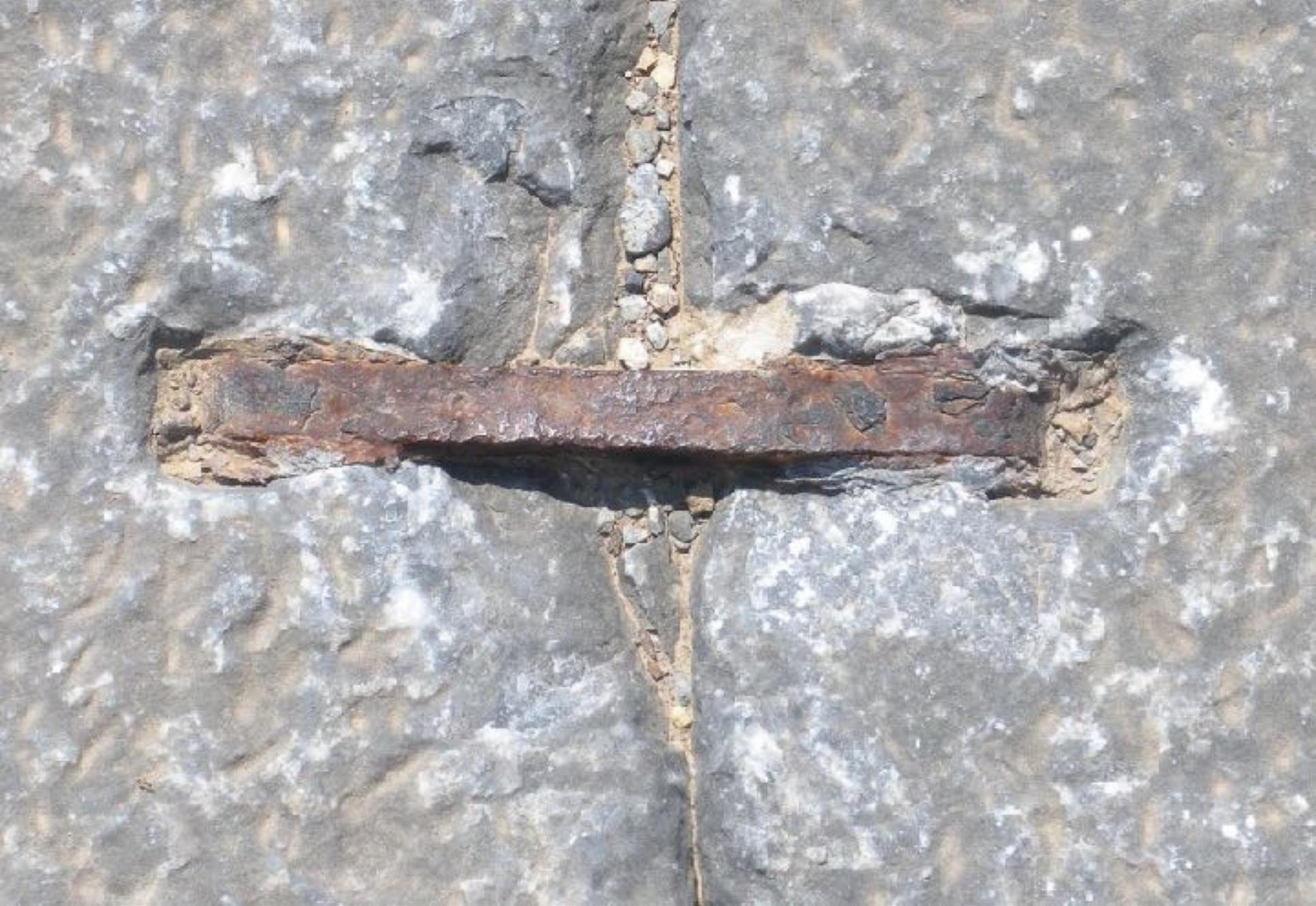
Scellement : agrafe en fer dans une gaine de plomb (partiellement conservée)
